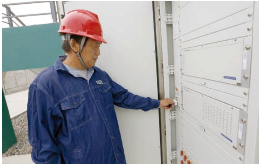
许志强正在110千伏贤城变电站查验电气设备安装情况
