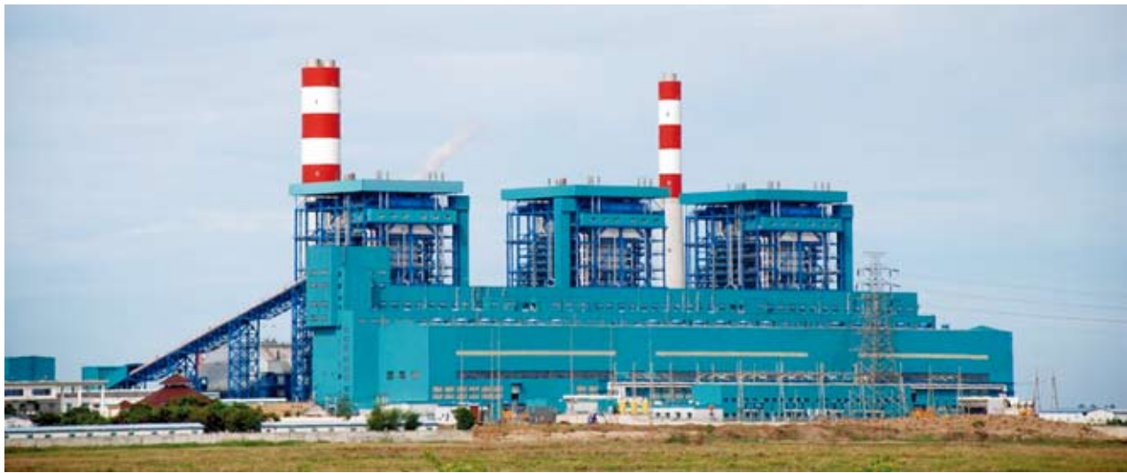
承建的印尼龙湾电站工程获2012年度境外优质工程奖，王涛拍摄
