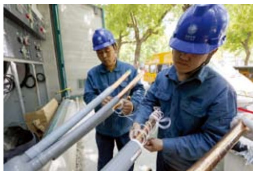
4月26日，国家电网滨州供电公司电缆运检班正在为滨州医学院附属医院敷设10千伏专用电缆，保障医院夏季安全可靠供电。
