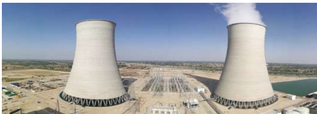
萨希瓦尔燃煤火电项目
