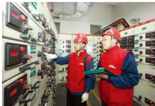
国网高密市供电公司彩虹共产党员服务队队员排查高密市人民医院用电安全隐患
