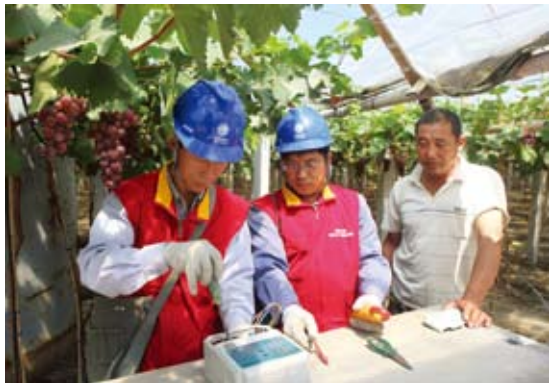
国网高密市供电公司阚家供电所员工对阚家镇松兴屯村葡萄园用电设备进行检查
