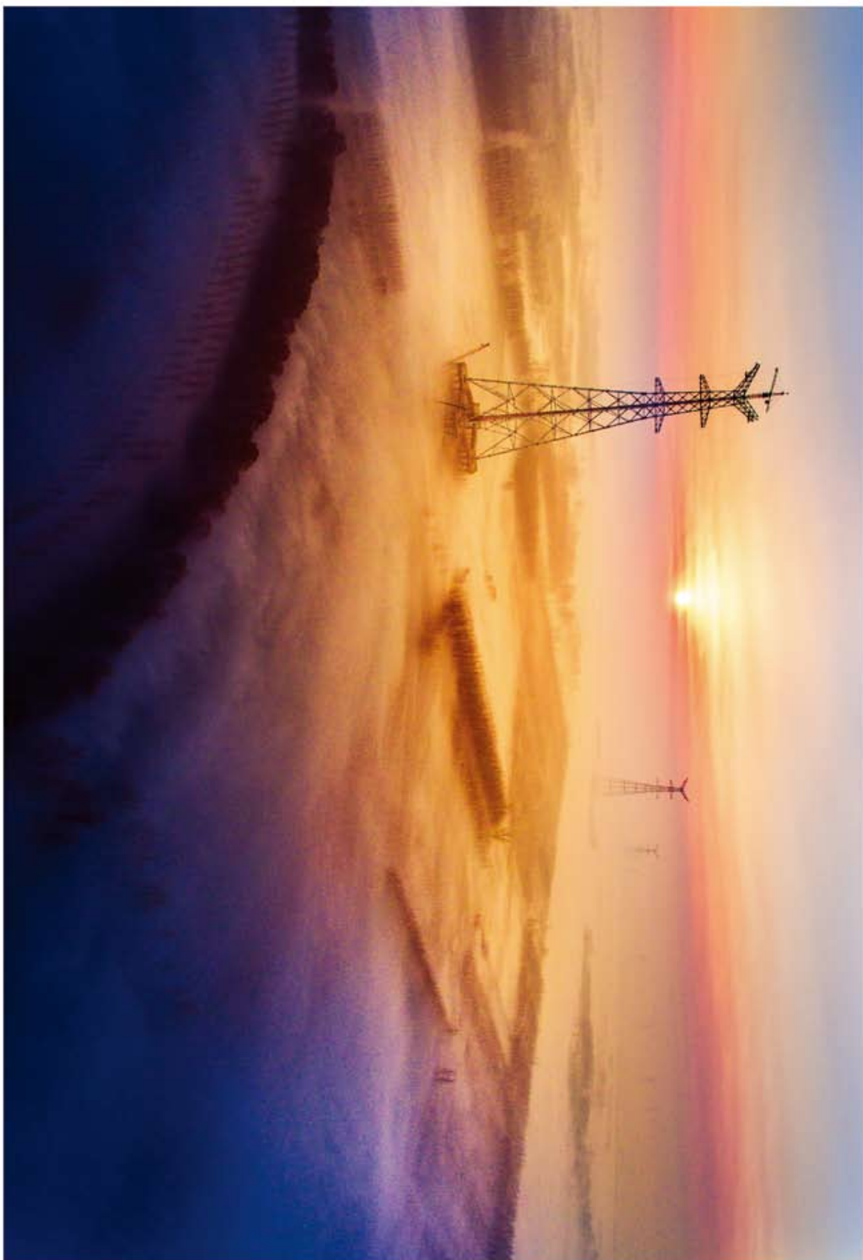
晋内最高跨黄河铁塔——榆横-潍坊1000千伏特高压输电线路工程第三标段 山东送变电工程公司 田世超/摄
