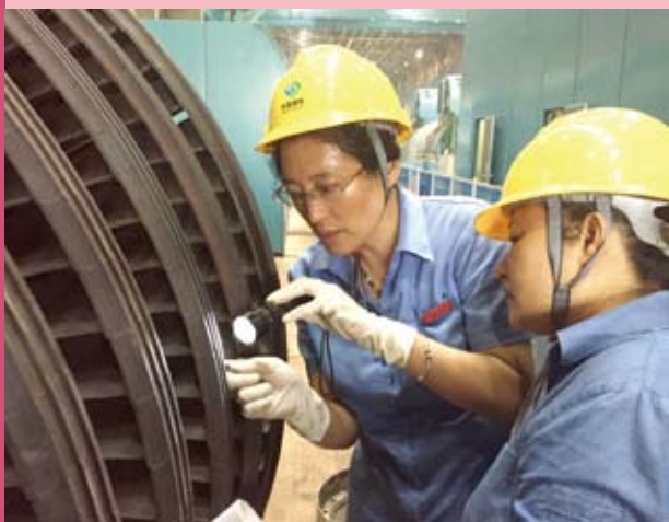
刘志娟带领工作人员到机组检修现场对汽轮机叶片刮垢取样，分析机组一个大修周期结垢情况，为生产技术部提供是否更换汽轮机叶片的数据依据
